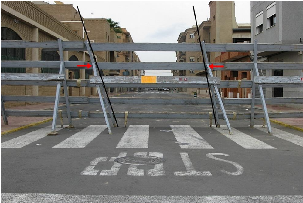
Barrera con tijeras inclinadas: Riesgo de plegado.
