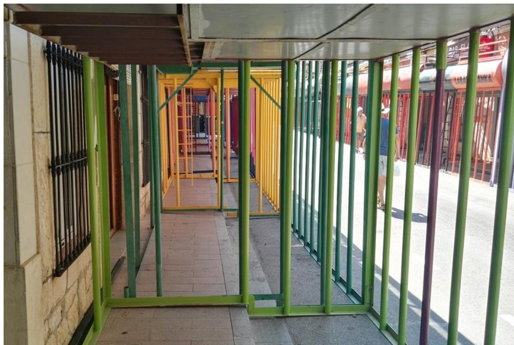
Hilera de cadafales con pasillo "accesible" para heridos en camillas, a través de barreras transversales.
