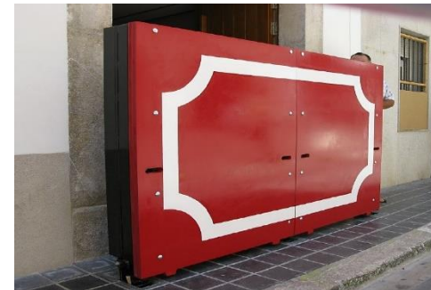
Burladero con estructura anclada solo a suelo.
