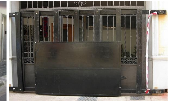
Barrera vertical con tablero superpuesto.
