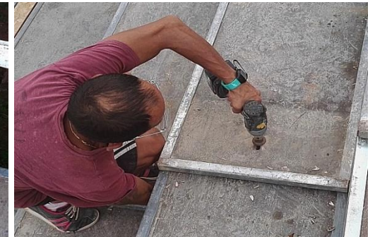
Fijación de tablero superpuesto. Resalto de 3 cm.
