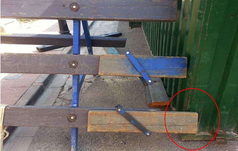
Acodalamiento lateral de una barrera de tijera por prolongación y con uso de brida metálica.
