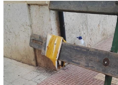
Acodalamiento con brida metálica protegida.
