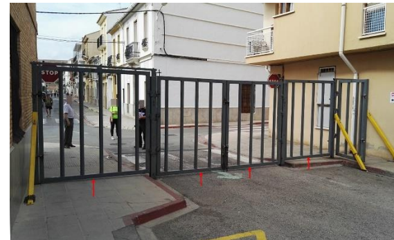
Barrera ajustada a las diferentes rasantes de la calle.
