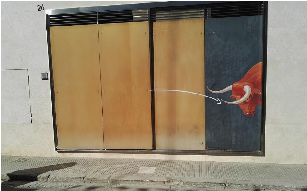
Magnífico ejemplo de protección de puerta de acceso a vivienda.
