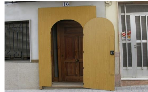
Otro buen ejemplo de protección de puerta.
