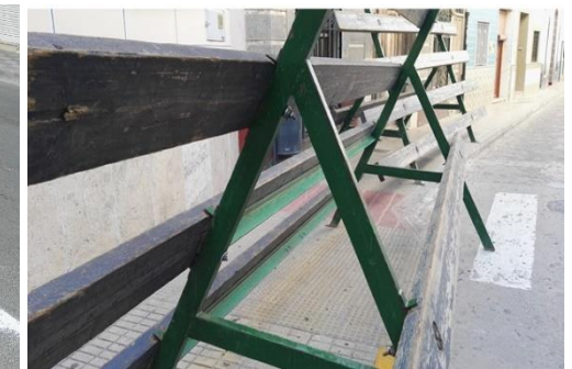
Barreras con perfiles en T en el tramo entre tijeras.
