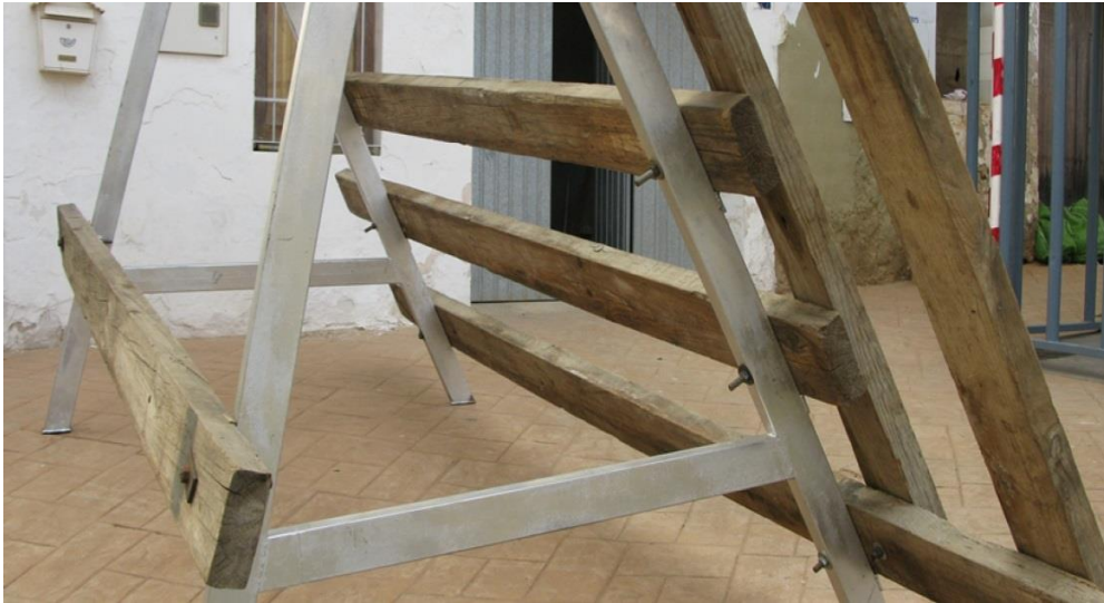
Barrera de Tijera SIN refuerzo en el trasdós de sus dos primeros tablones.
