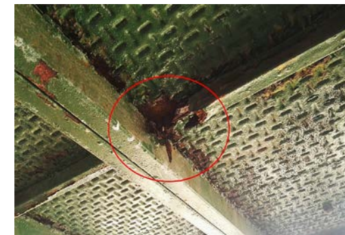
Grave oxidación en perfil.
