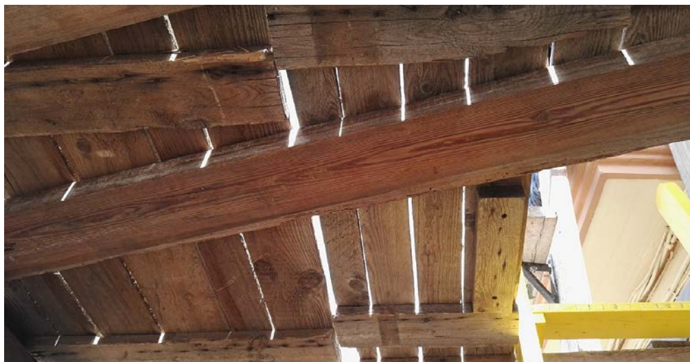
Viguetas y tablero de la plataforma con elementos madera.
