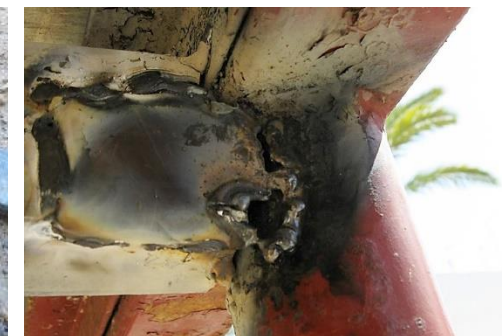
Soldaduras deficientes.
