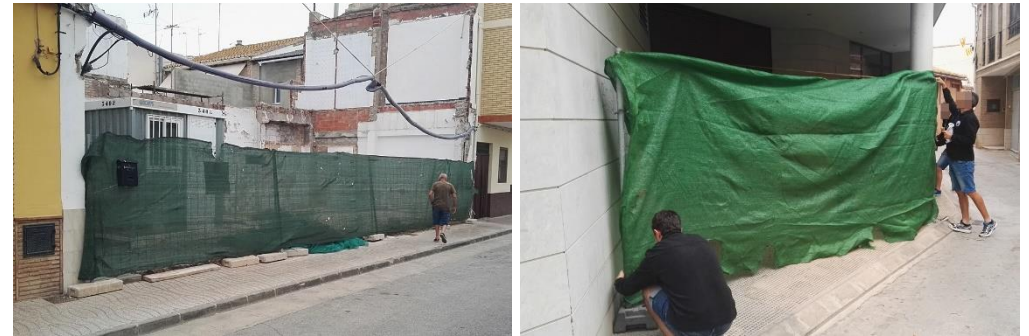
Cerramientos provisionales flexibles y no resistentes.
