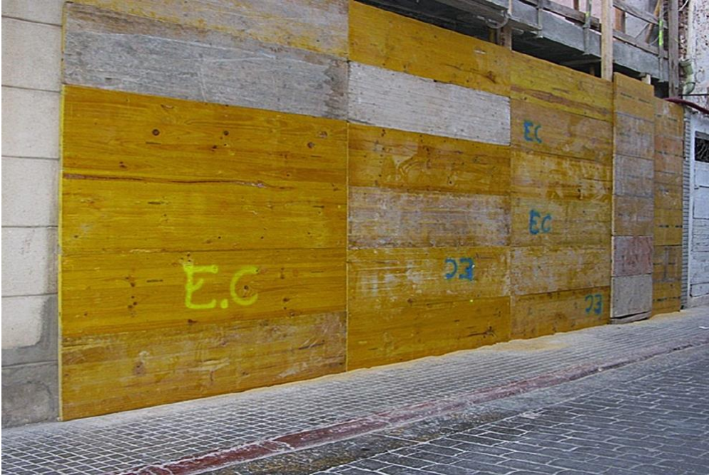
Cerramiento provisional de obra rígido y resistente.
