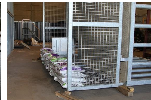
Cadafal durante prueba de carga de la barandilla.
