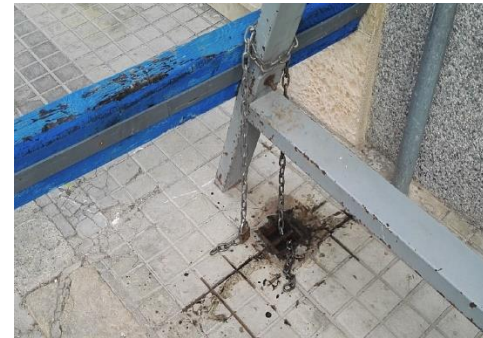
Anclaje con cadena desde tijera de borde a argolla.
