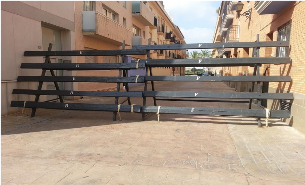
Mínimo: Dos anclajes al terreno por cada barrera de tijera.
