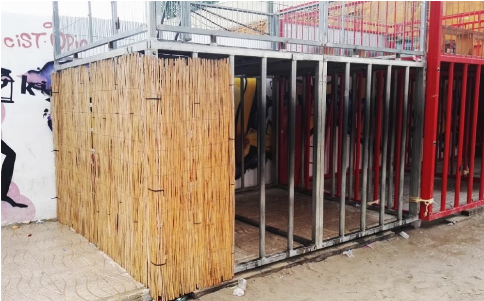
Cadafal con protección de escalera mediante cañizo.
