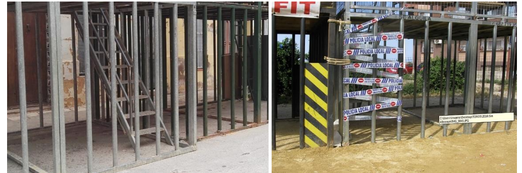
Ejemplo de escalera de cadafal con riesgo.
