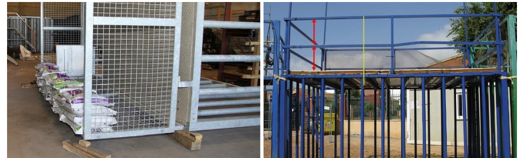
Ensayo de resistencia de barandilla en voladizo.
