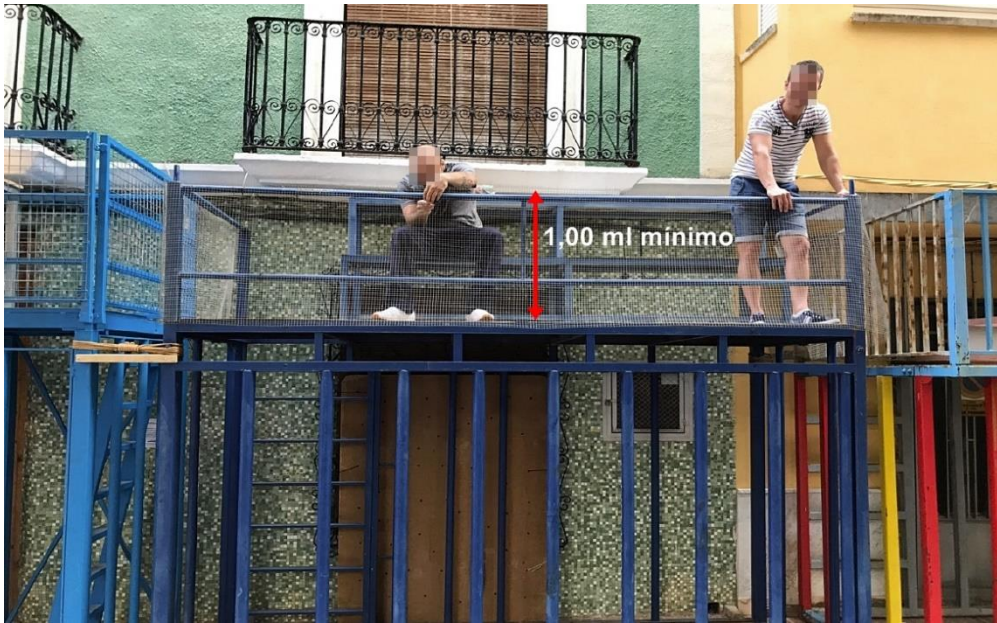
Cadafal con altura de barandilla inferior a 1,00 ml.
