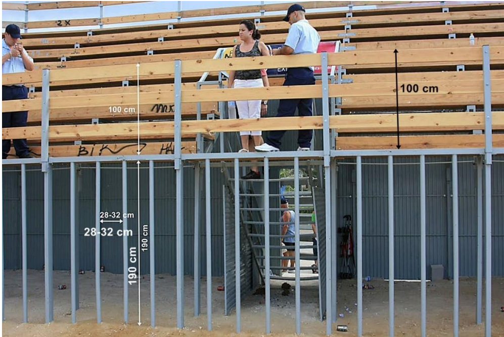
Plaza de toros portátil constituida como Recinto Taurino, de barrera vertical.
